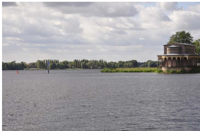
Heilandkirche in Sacrow ohne den 2011 eingerüsteten Turm
